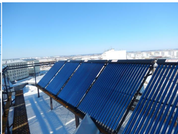
4. Солнечные коллектора ГВС
